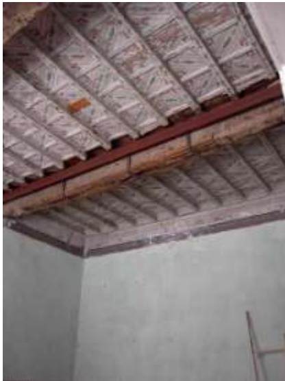
Piano primo, vano voltato aggiunto nel 1879, e vani con solai in legno a regolo per convento
