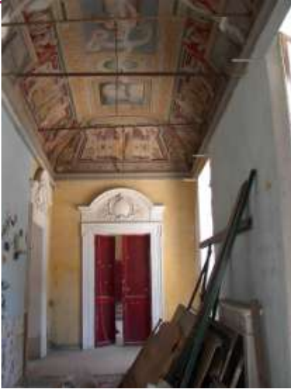
Piano primo, vano voltato aggiunto nel 1879, e vani con solai in legno a regolo per convento
