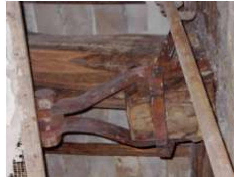
Attacco del tetto alla muratura portante
