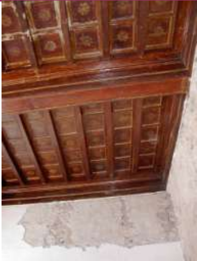
Piano secondo, vano con solai in legno a regolo per convento, parete interna con sopra luce e camini
