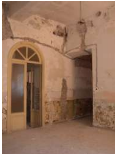
Piano secondo, vano con solai in legno a regolo per convento, parete interna con sopra luce e camini
