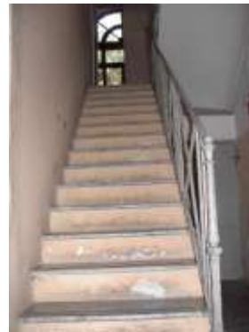
scala di accesso al piano seminterrato
