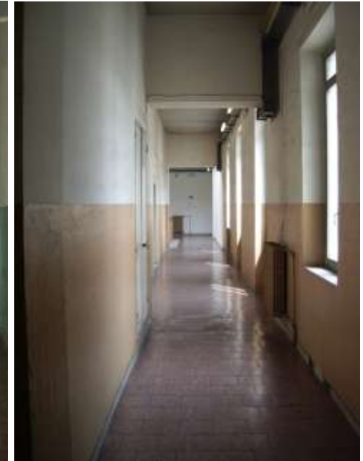
corridoio di collegamento tra le scale (terzo piano)
