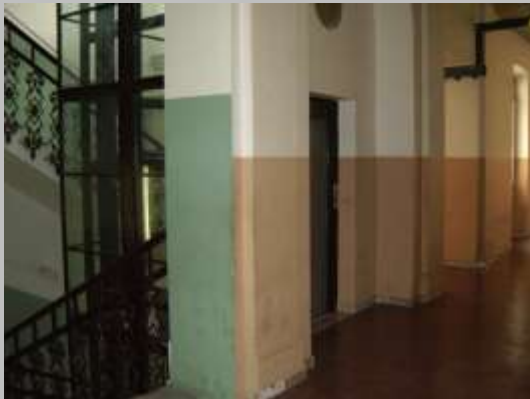
inserimento dell'ascensore nelle scale verso via Frangipane
