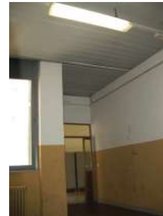
corridoio di collegamento tra i corpi scala
