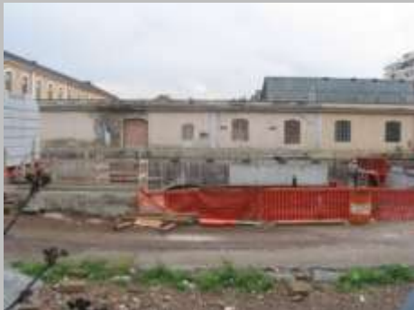
Centro per le Arti Contemporanee in costruzione
