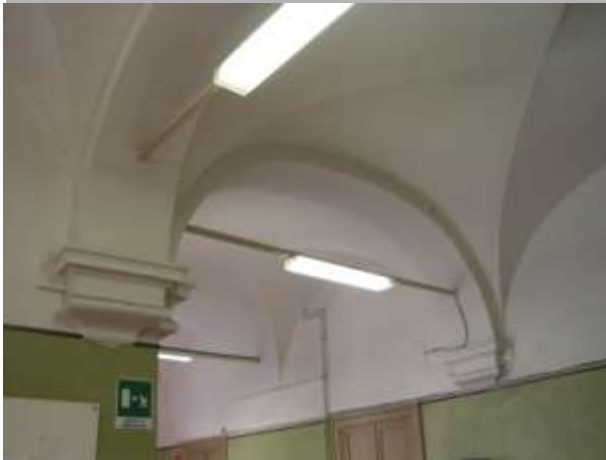
Particolare del portale sul corridoio; volte del corridoio anulare; prospetto dell'ampliamento (Isacco Newton) prospetto su via dell'Olmata (Leonardo da Vinci)
