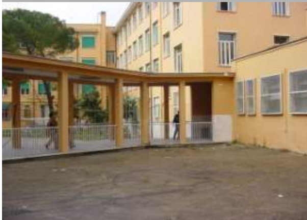
Il cortile interno, la pensilina
