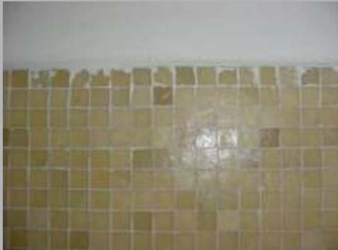
Rivestimento delle pareti del vano scala
