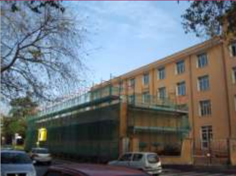
Il cantiere sul fronte via Argentina
