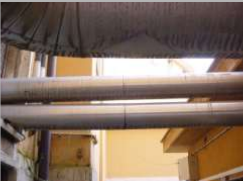
Collegamento tra la cabina del metano e l'edificio scolastico del '58
