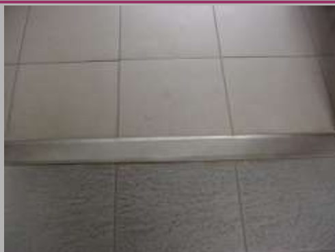
Pavimentazione dell'atrio in gres
