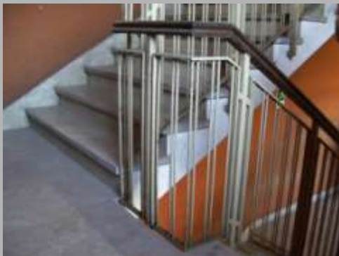
vano scale a nord, particolare della ringhiera e dei materiali
