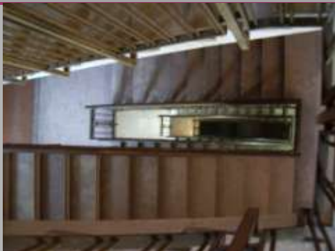
vano scale a nord
