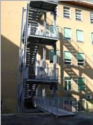
le scale di sicurezza sulla facciata
