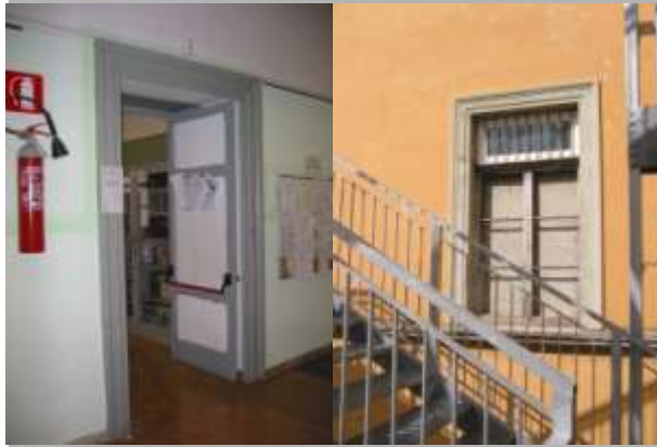
Gli infissi originali: quelli interni arretrati e quelli esterni sulla scala tamponata e quindi non sostituiti
