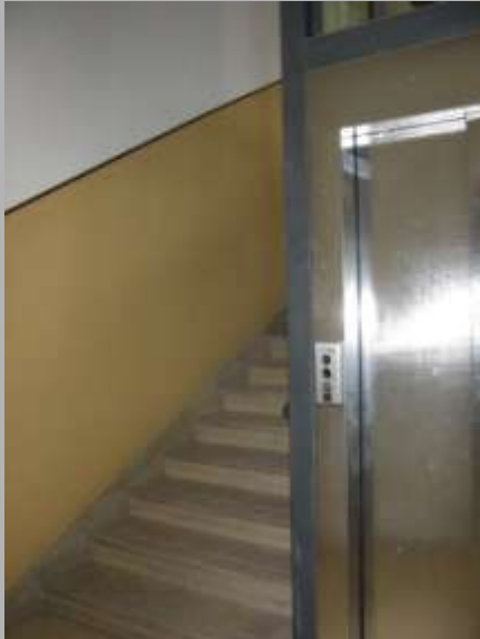
L'ascensore e le scale compartimentate
