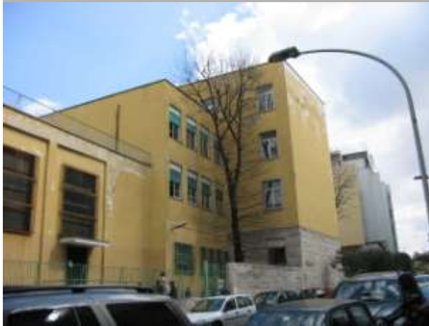
Il prospetto su via Schiapparelli
