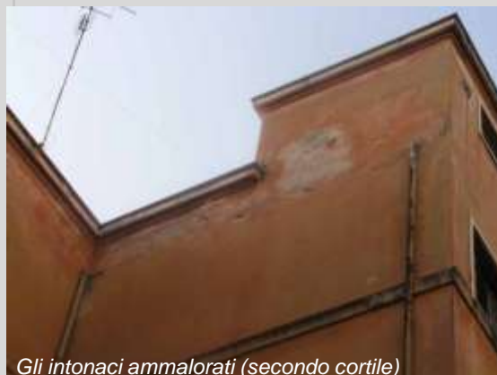
Gli intonaci ammalorati (secondo cortile)
