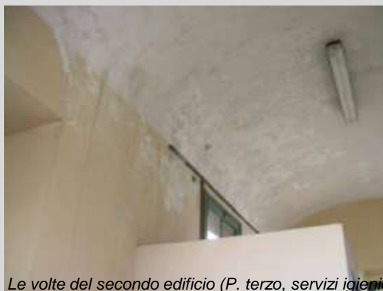
Le volte del secondo edificio (P. terzo, servizi igienici)
