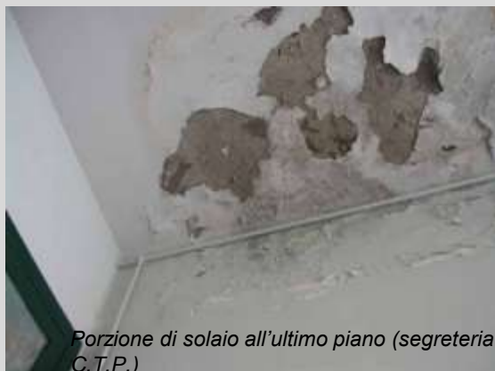
Gli intonaci ammalorati (secondo cortile)
