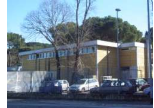
2005, prospetto della ex palestra vista da viale della Moschea (prospetto Nord)
