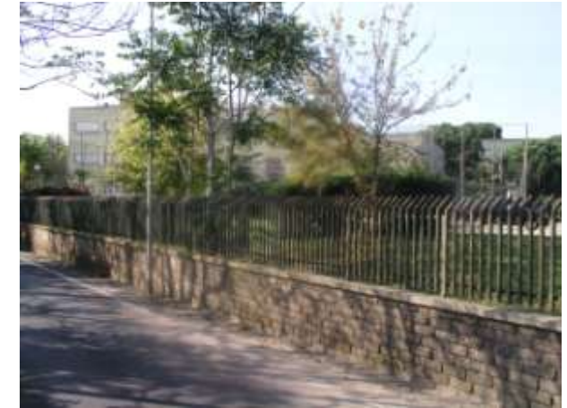
Il recinto su via Labico, sul fondo il fabbricato scolastico
