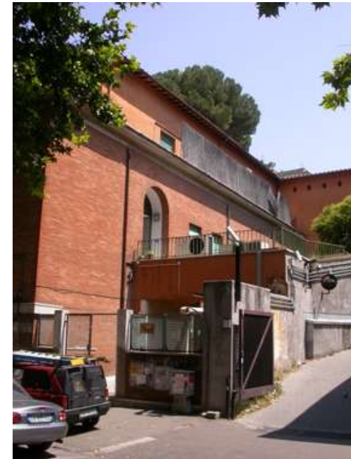
Cancello di ingresso da via Angelo Emo
