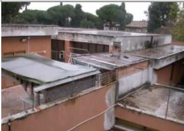
Le coperture della palestra e dell'alloggio del custode
