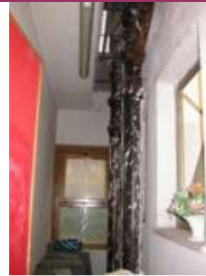
Pluviali e bucatore nuove dei bagni nel ripostiglio
