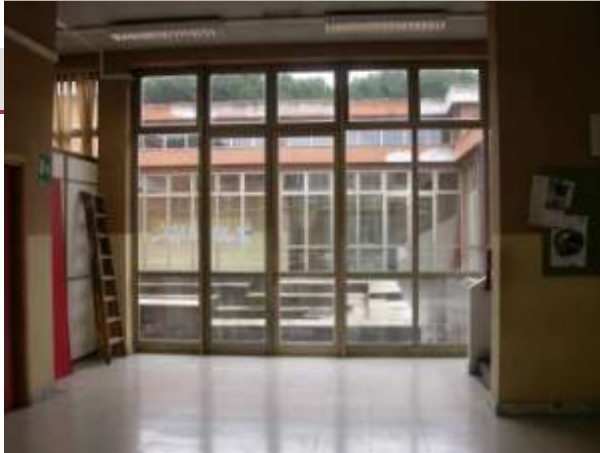
Gli infissi in alluminio anodizzato sostituenti gli originari
