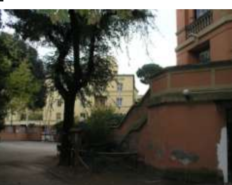
Lato della scalea di accesso
