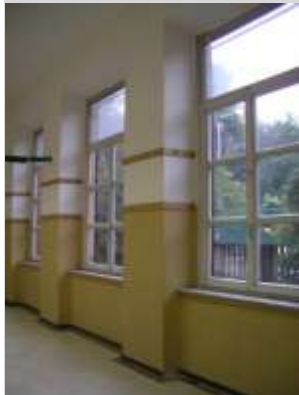
Corridoio del piano primo
