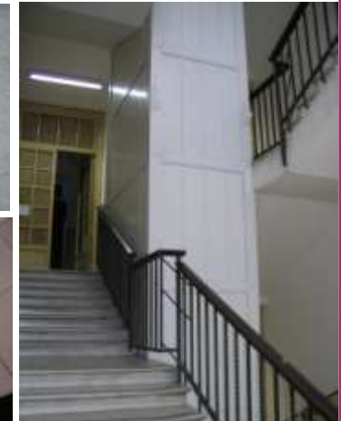
Colonna ascensore, posizionata all'interno del corpo scala
