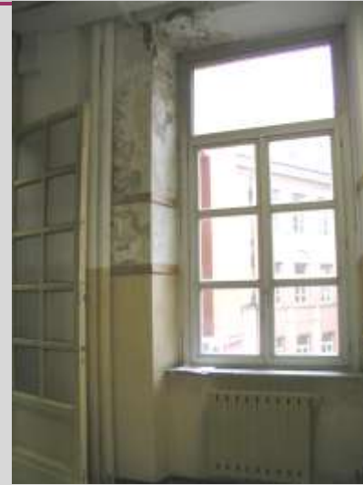
Infiltrazioni d'acqua al p. rialzato
