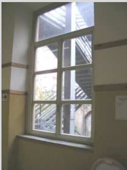
Una delle scale di sicurezza vista dal corridoio del p. rialzato
