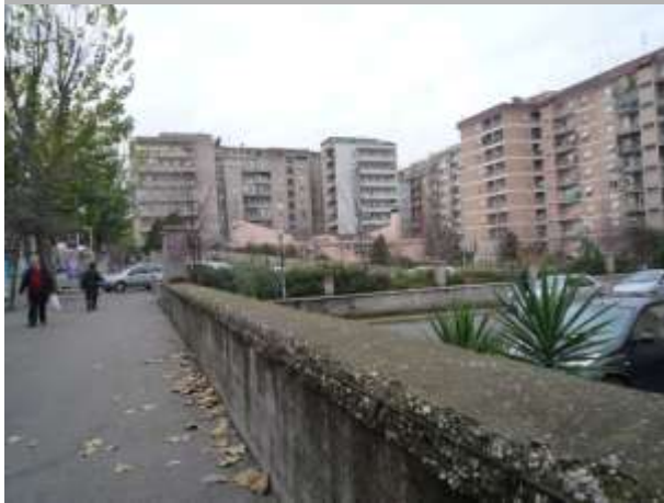
Area esterna su via Giustiniano Imperatore
