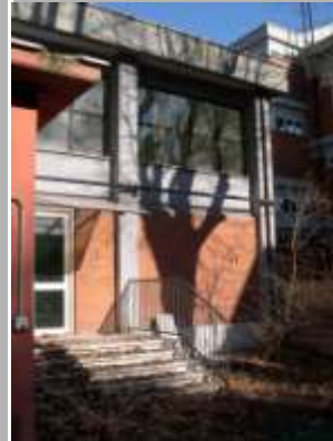
vetrata di comunicazione tra antipalestra e giardino
