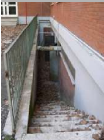
l'accesso all'ex centrale termica
