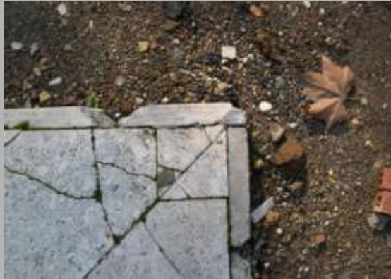
dettaglio del marciapiedi in travertino del giardino
