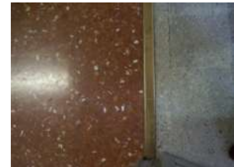
pavimentazione in marmettoni bianchi e rossi
