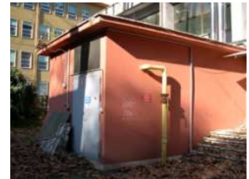
la centrale termica
