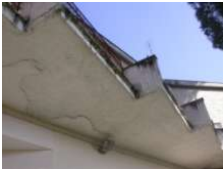
Infiltrazioni d'acqua sotto il balcone e pavimento consunto sopra
