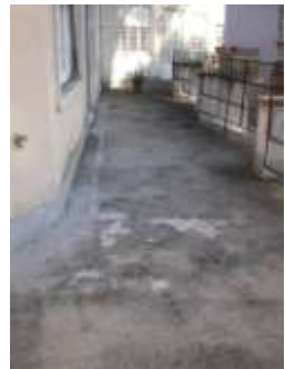
Infiltrazioni d'acqua sotto il balcone e pavimento consunto sopra
