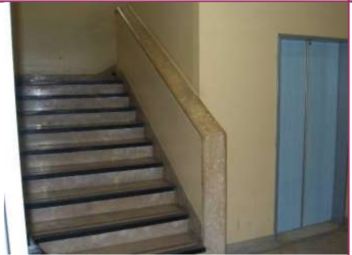
La scala con l'ascensore interno nell'edificio del 1951
