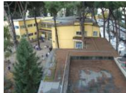
Copertura dell'alloggio del custode
