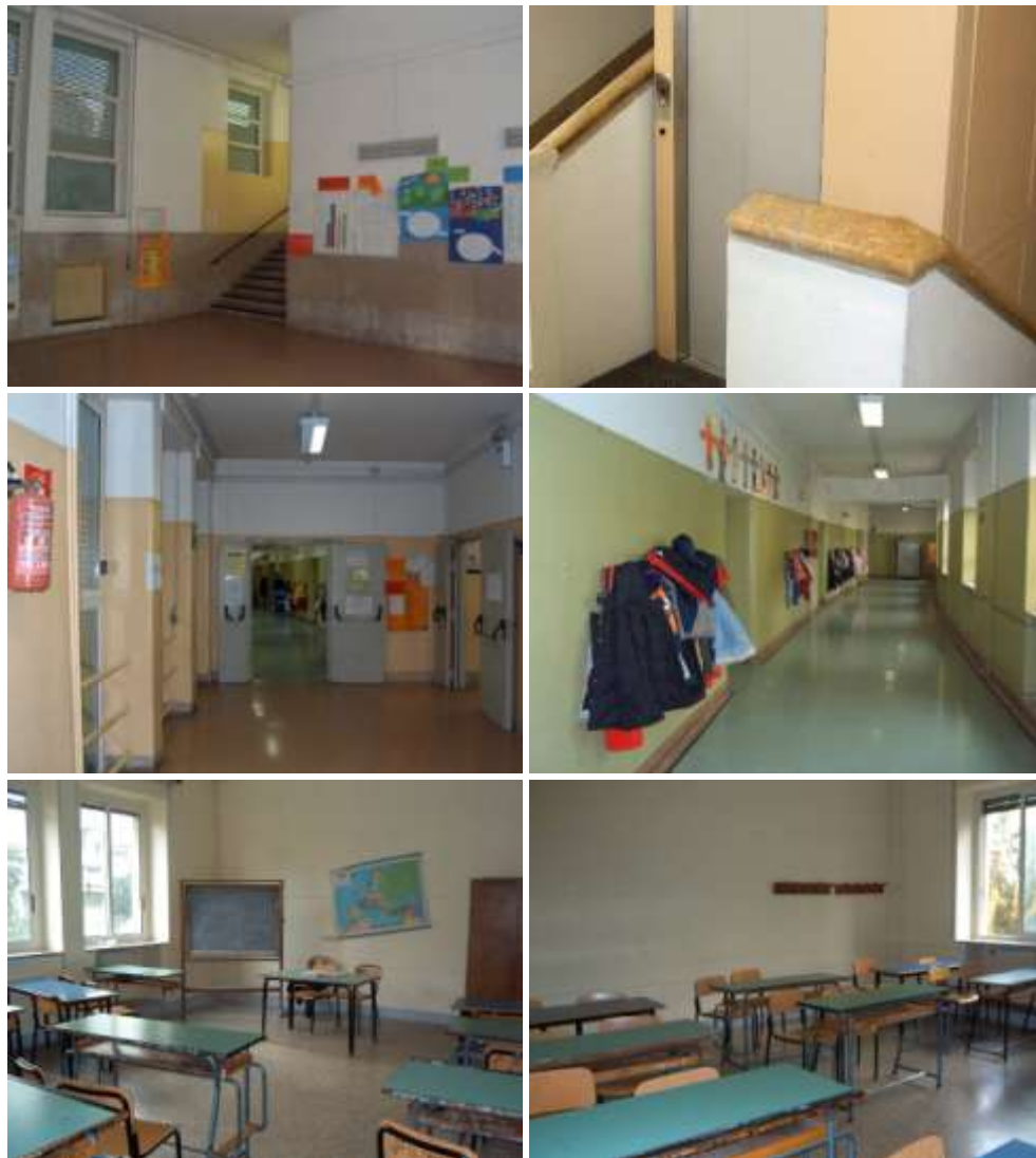
L'edificio del 1953: scala; corridoi; aule
