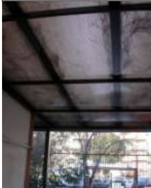
Pensilina di ingresso
