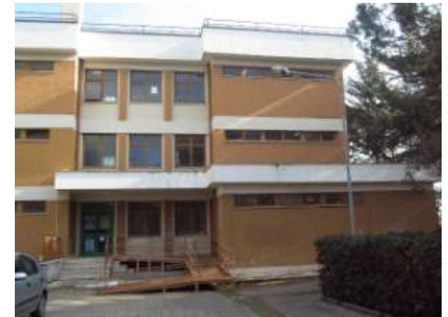
Rampa per disabili
