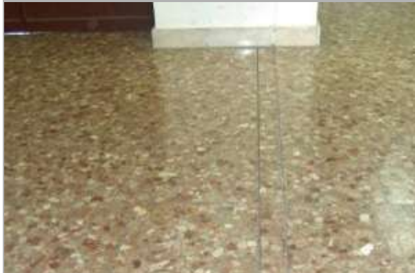
Pavimentazione in graniglia
