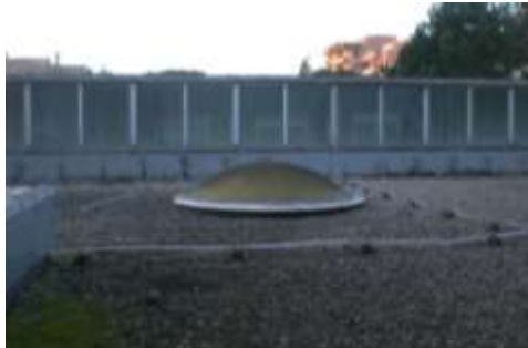
Un lucernaio a cupola e gli shed in copertura
