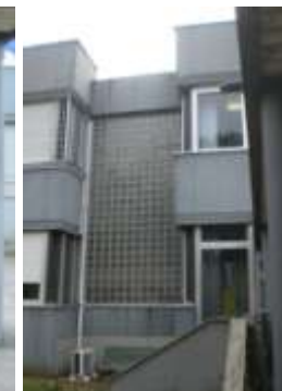
parete in retrocemento
