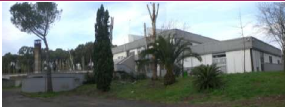
la scuola dal lato della centrale termica
