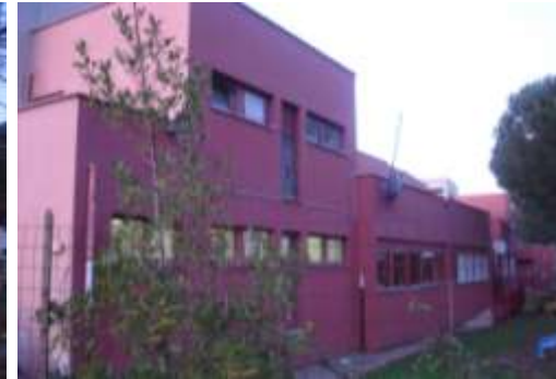
Prospetto verso il cortile
