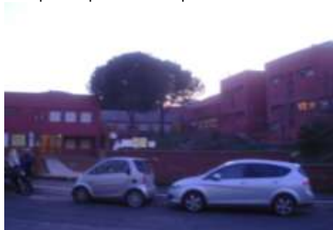
L'ingresso su via Ballarin
