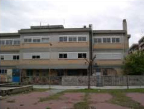
parte del prospetto ad est, in corrispondenza dell'ex alloggio del custode
