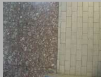
pavimenti del corridoio e dei servizi igienici
