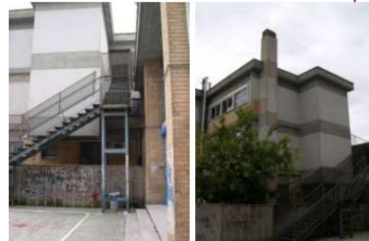
inserimento delle scale di sicurezza (nord)
