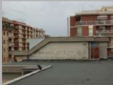
terrazzo di copertura
