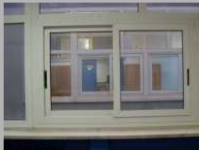
finestra sul piccolo patio
