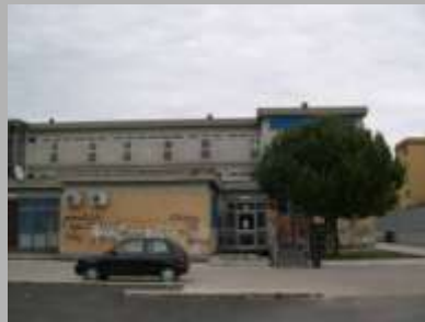
prospetto ovest all'altezza dell'ingresso secondario
