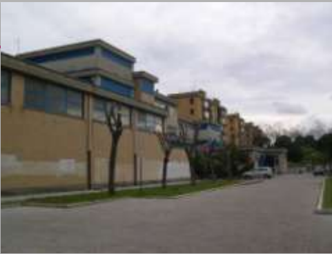
scorcio del prospetto ovest, , in primo piano è la palestra
