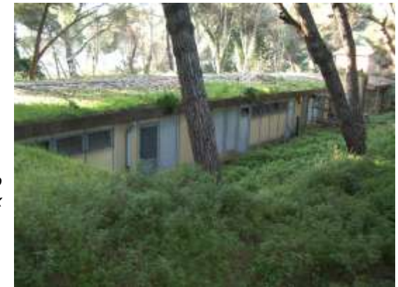
l'area del futuro ampliamento (ex scuola Ferrini).
