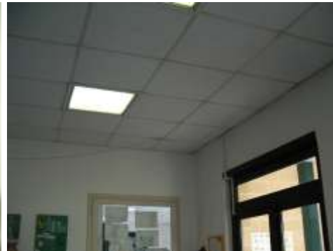
plafoniere incassate nel controsoffitto
