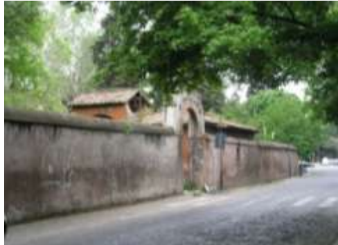
Veduta dell'ingresso alle scuole e al Parco da via di Porta San Sebastiano, 2.
