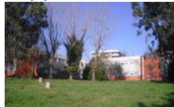
l'edificio visto dal declivio del giardino sul retro
