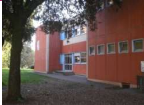
prospetto al lato dell'ingresso
