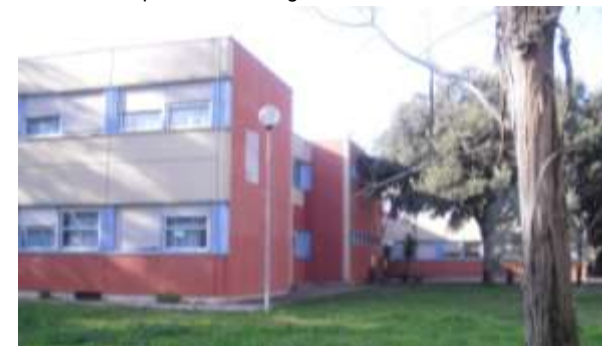
il prospetto laterale
