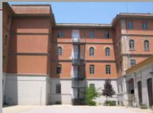
Scale di sicurezza e ascensore verso la corte
