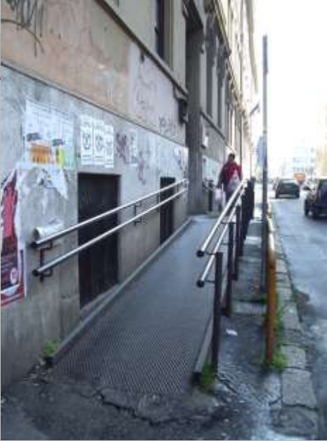
rampa per disabili su via dei Sardi
