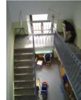
scala di collegamento con il terrazzo di copertura
