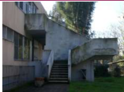
la scala di sicurezza in c.a.
