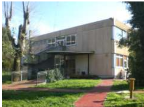
prospetto su via Andrea del Castagno
