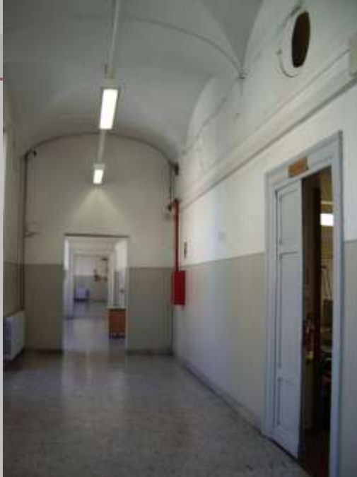
particolare del corridoio - edificio originale
