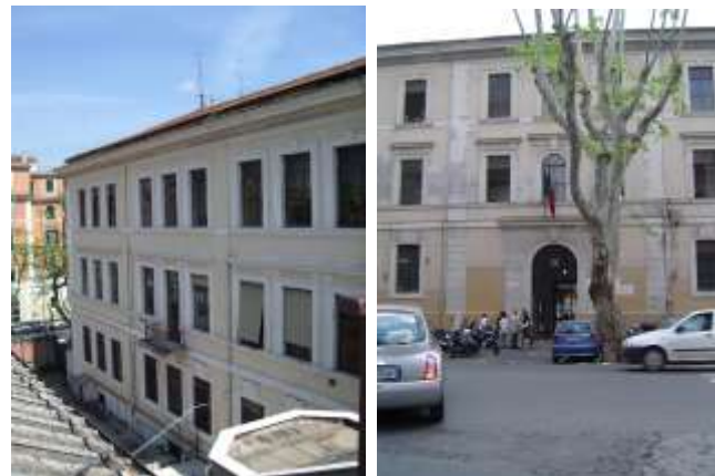
prospetto verso il campo sportivo e ingresso principale- edificio originale
