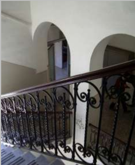
corpo scala senza ascensore- edificio originale
