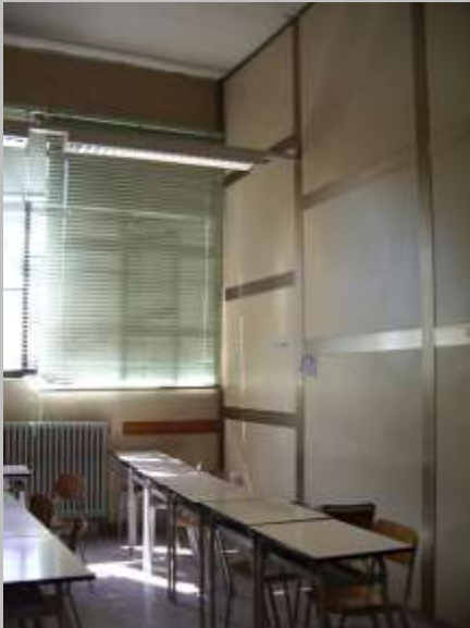
interno di un'aula - ampliamento
