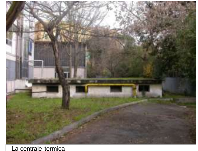
La centrale termica
