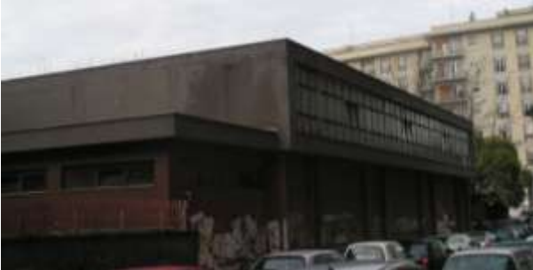
Fronte Est, il corpo della palestra
