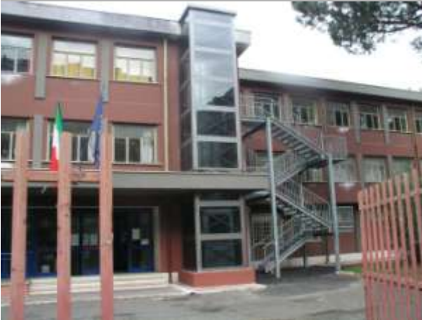
Fronte Sud, il cortile di accesso alla scuola su via Di Giacomo, la scala di sicurezza e l'ascensore.
