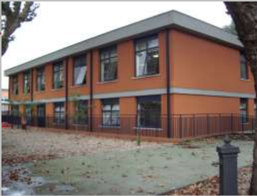
la facciata a sud - scuola materna
