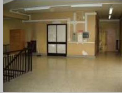
particolare dell'atrio - scuola media
