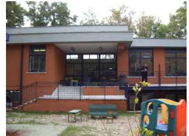
accesso al giardino a nord - scuola materna
