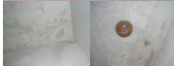
*Infiltrazioni idriche: aula a gradoni, spogliatoi e servizi; in basso lo stato delle coperture, solo una parte è stata impermeabilizzata di nuovo*
