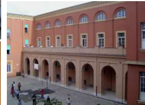
Il cortile dell'edificio del 1930
