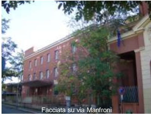
Facciata su via Manfroni
