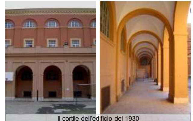
Il cortile dell'edificio del 1930
