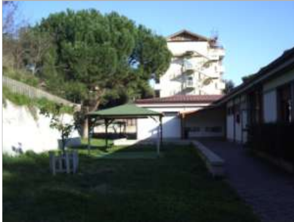
La parte di giardino a nord, alla quota degli ingressi e la parte a quota superiore non fruita e sostenuta dal muro
