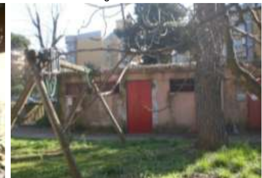
la centrale termica
