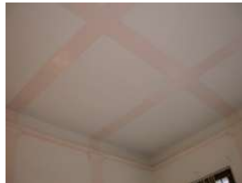
pareti e soffitti decorati in mensa
