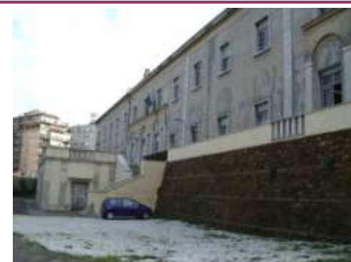
scorcio del prospetto principale
