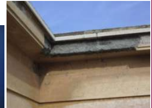
dettaglio della facciata a sud
