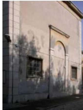
Dettaglio del fronte sud
