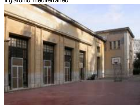
facciata a sud ovest
