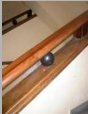
dettaglio della scala
