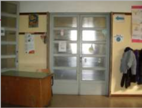
porta finestra di un'aula al primo piano
