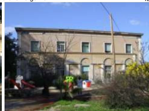
facciata a ovest (lato via Padre Semeria)
