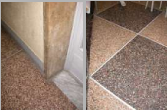
pavimento del corridoio e della mensa al piano terra
