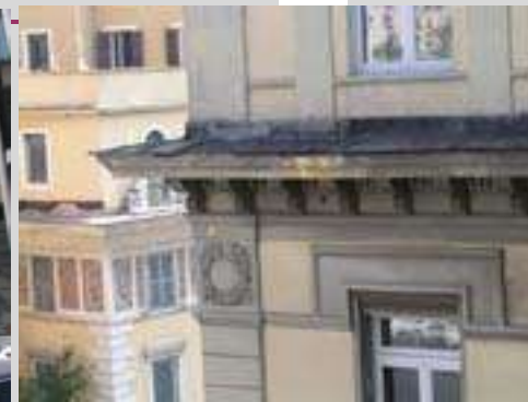
Prospetto su via S. Porcari e dettaglio del cornicione.
