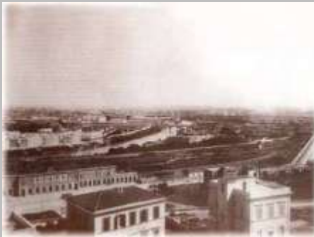
Stazione a viale del Re oggi viale Trastevere 1920
