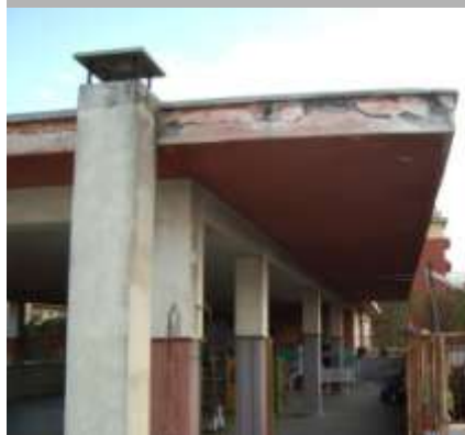
degrado dei frontalini e dei parapetti del terrazzo coperto
