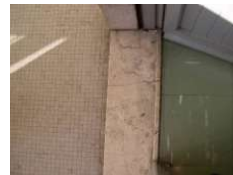
pavimenti dell'asilo nido (linoleum) e del balcone (mosaico in pasta vetrosa)
