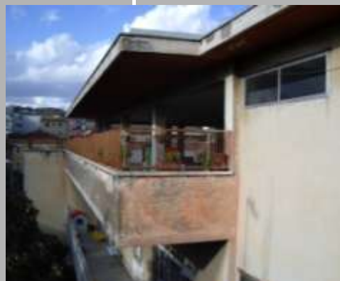
degrado dei frontalini e dei parapetti del terrazzo coperto
