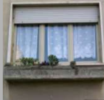
degrado delle fioriere sul prospetto laterale
