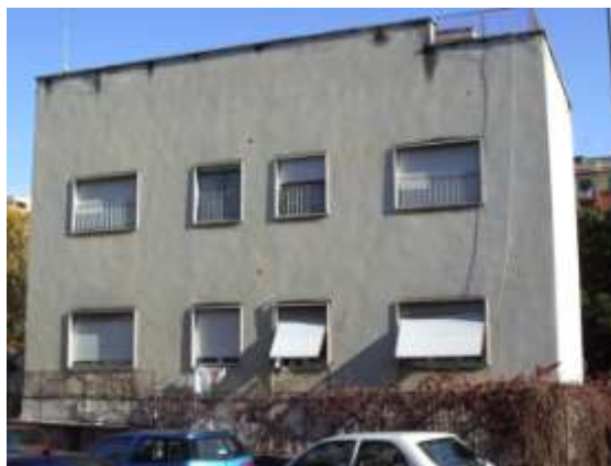
prospetto su via Alberico da Barbiano
