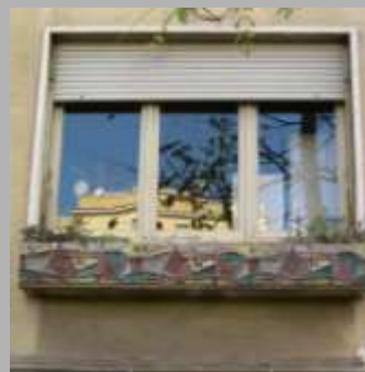
degrado delle fioriere sul prospetto laterale
