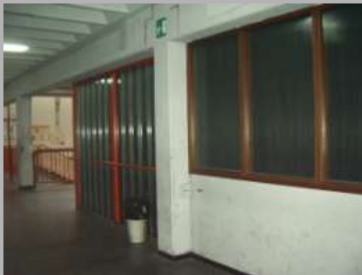
corridoio al I piano, finestre e vetrata sull'auditorium
