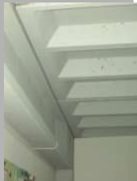
attacco del solaio alla trave
