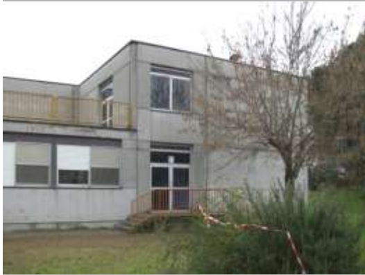
particolare del lato a nord ovest
