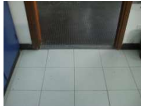
dettagli dei pavimenti di un bagno e della biblioteca
