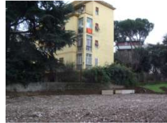
campo sportivo in costruzione
