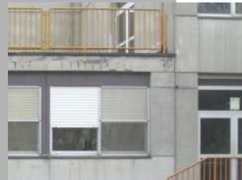
dettaglio della facciata a nord-ovest
