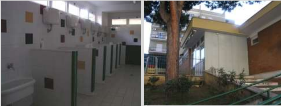
I servizi igienici ristrutturati e l'esterno dell'aula ricavata nell'atrio originario
