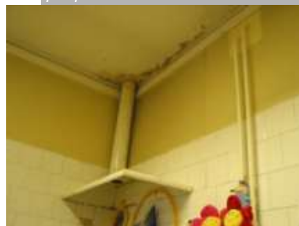
Le parti ammalorate per problemi di umidità
