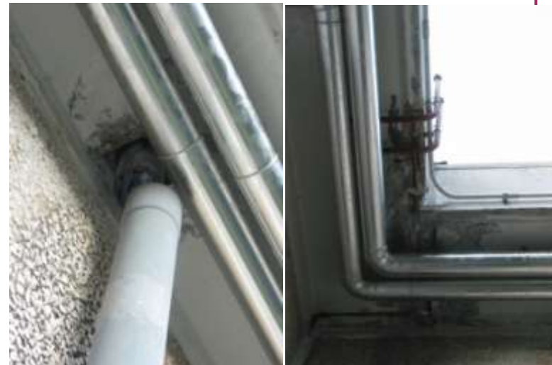
Parte del discendente non collegata con il canale di gronda
