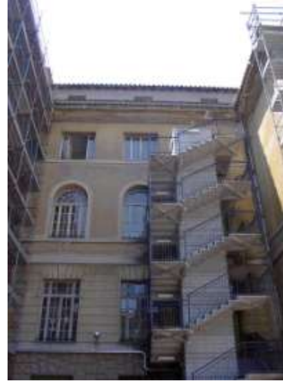
Scala di sicurezza
