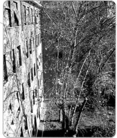
15 - SCUOLA IN LARGO ORIANI, VIA BARRILI, AMPLIAMENTO DEL 1952, PROSPETTO SUL CORTILE
