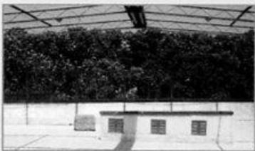
parapetti della terrazza sono stati rialzati sino ad un'altezza di circa 2,00 m con una rete metallica; la copertura della scala è a tetto.
